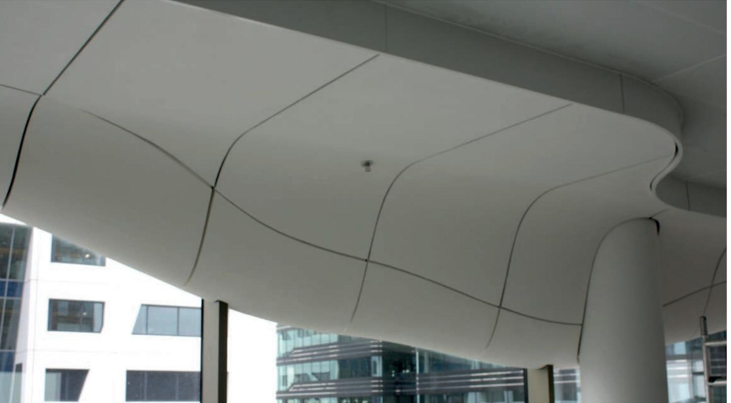
Für ein Bürogebäude in der holländischen Stadt Utrecht hat die Firma Curve Works vor kurzem mit A1 Platten eine wunderschöne doppelt gewölbte Decke gebaut. Neben der Tatsache, dass die A1 Platten mit Glasfasergewebe verstärkt wurden, ein niedriges Gewicht haben und von Formfreiheit gekennzeichnet sind, verfügen sie außerdem auch über die erforderliche Brandschutzklassifizierung.
