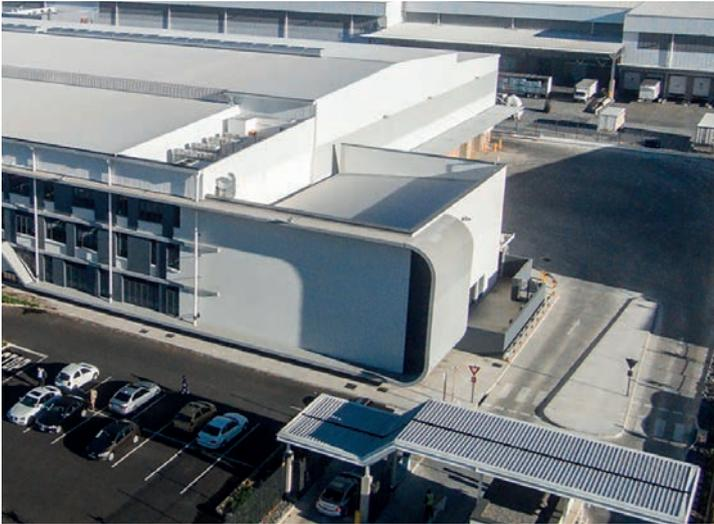
Die EPS-Blöcke der beeindruckenden Betonelemente bestehen aus mehreren mit Glasfasergewebe verstärkten Schichten A1. Durch das Hinzufügen von Pigmenten und Sand zur A1 Masse entstanden die Atmosphäre und die Optik einer leichten, einzigartigen „Beton“-Fassade.
